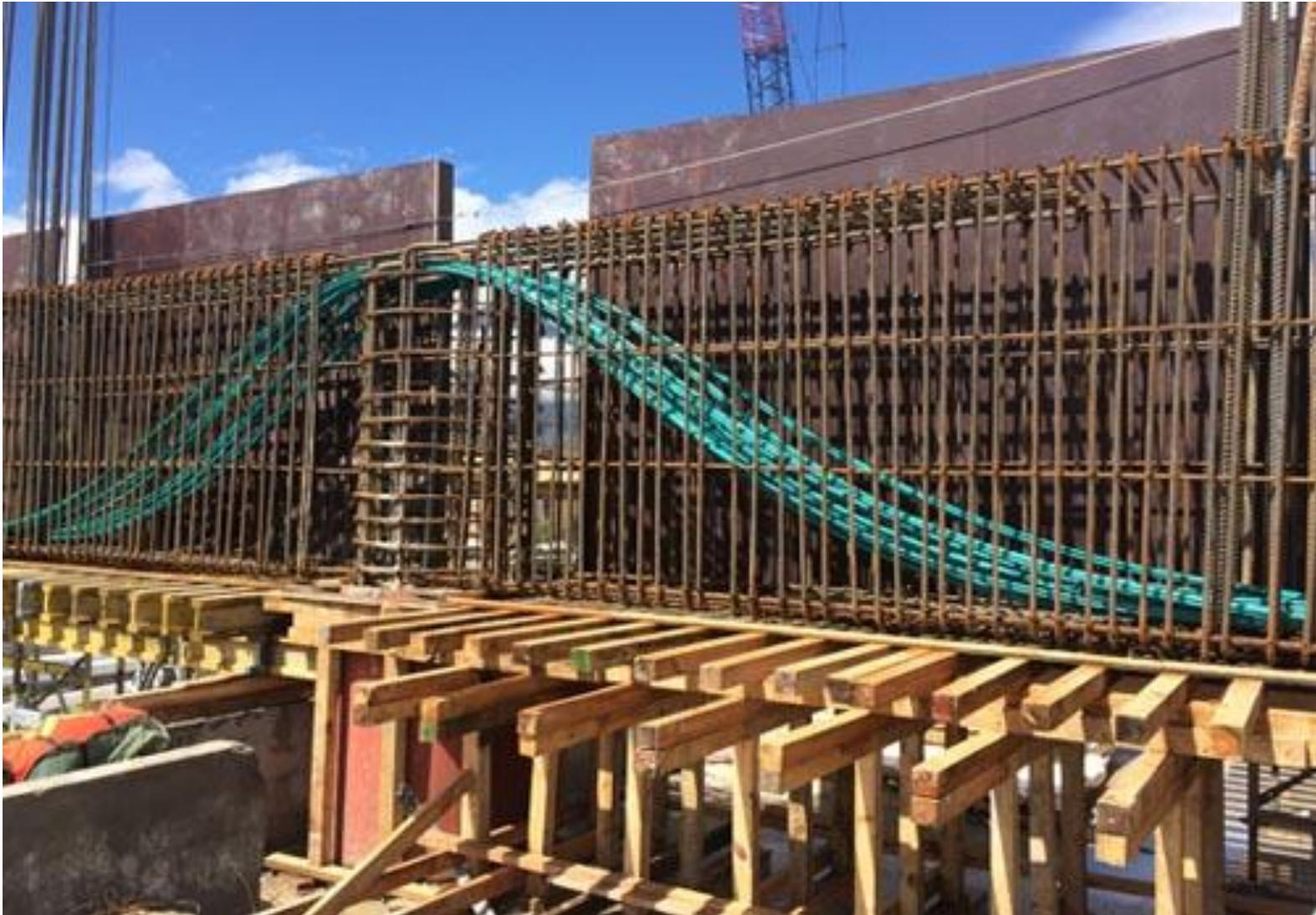
Preparación previa de una viga continua postesada con cables no adherentes
