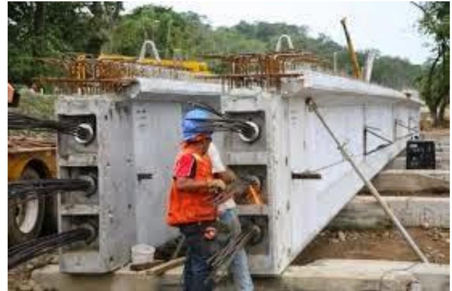
Se introduce la pasta de cemento al interior de las vainas por uno de los extremos, a alta presión, y se continua el bombeo hasta que la lechada aparece en el otro extremo del tubo. La pasta endurecida une al cordón con la pared de la vaina.
