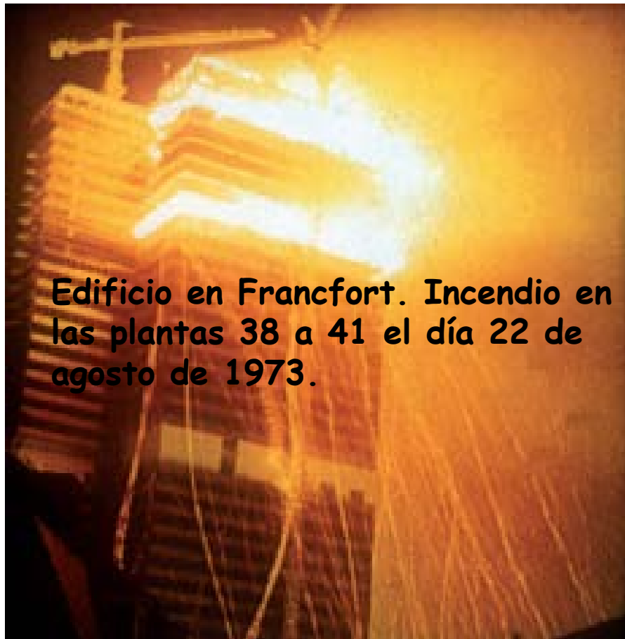
Resistió el incendio de cuatro horas. Se desprendió el recubrimiento y las armaduras quedaron al descubierto.
