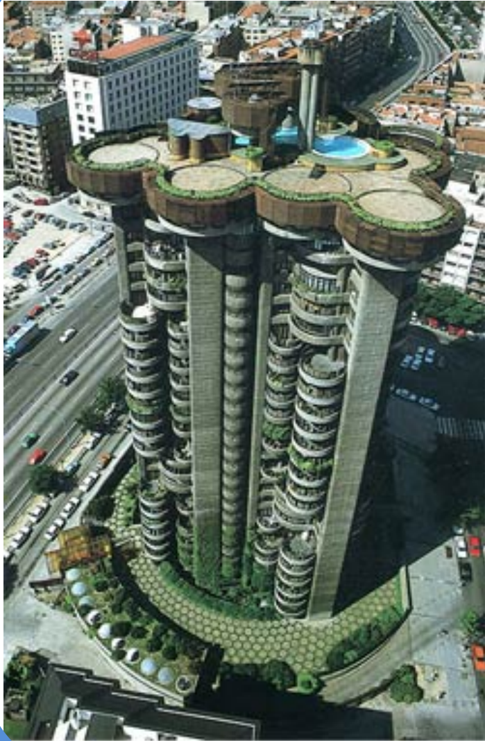
Vista aérea de Torres Blancas. – Madrid 1964
