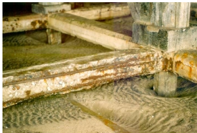
Figura 10: Corrosión del acero: a) por ingreso de cloruros en ambiente marino, b) por carbonatación en ambiente rico en dióxido de carbono (cochera subterránea).
