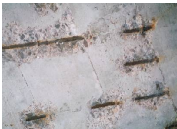
Figura 10: Corrosión del acero: a) por ingreso de cloruros en ambiente marino, b) por carbonatación en ambiente rico en dióxido de carbono (cochera subterránea).
